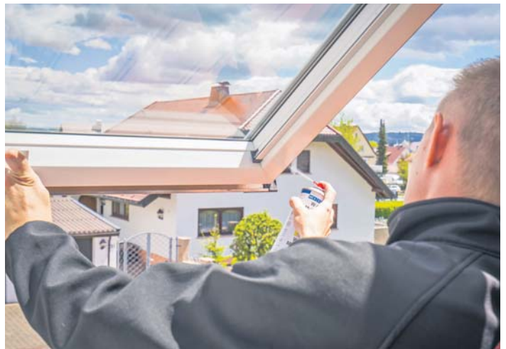
Ofť fehlt nur ein Tropfen Öl an der richtigen Stelle, manchmal muss eine Dichtung oder ein Teil des Beschlages ausgetauscht werden, damit ein Dachfenster wieder einwandfrei funktioniert. djd/Foto: TLS-Dachfenster
