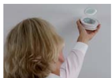
Magnetplatten an der Decke erleichtern den Austausch und den Batteriewechsel bei Rauchwarnmeldern. Foto: wwp
