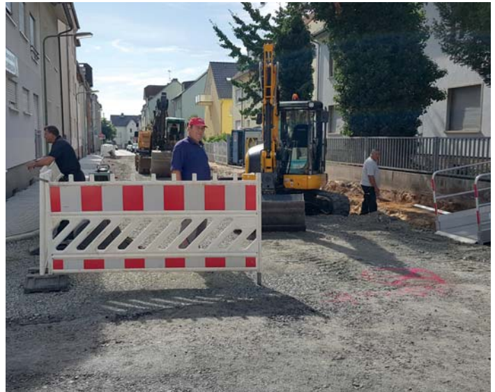
Grundsaniierung. Die Michaelstraße wird derzeit zwischen der Hachenburger- und der Mainberger Straße vollständig saniert. Der Vorarbeiter der Firma Peter Gross Bau ist aber zuversichtlich, dass die Arbeiten in dieser Woche abgeschlossen werden können.
